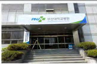
[부산대병원 융합연구동 전경]
